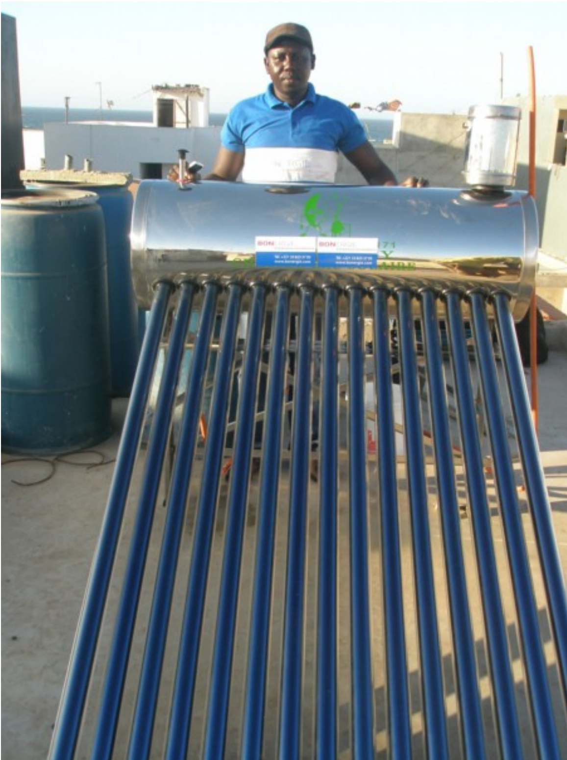
L'équipe de Bonergie Dakar installe un chauffe-eau solaire.
